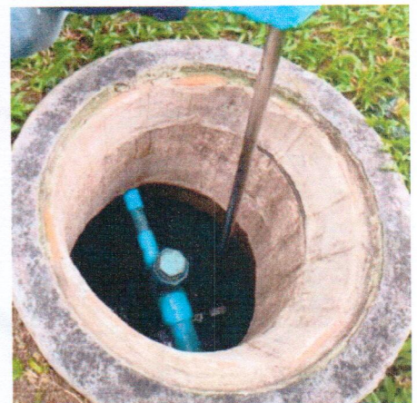
จุดที่ 2 คุณภาพน้ำทิ้งหลังจากการบำบัดน้ำเสีย บริเวณถังน้ำใส (Effluent tank)
