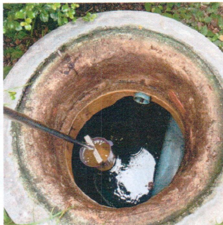
จุดที่ 1 คุณภาพน้ำเสียก่อนการเข้าสู่ระบบบำบัดน้ำเสีย บริเวณถังส่วนแยกกาก (Solid separation chamber)
