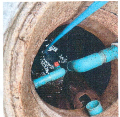
จุดที่ 2 คุณภาพน้ำทิ้งหลังจากจากระบบบำบัดน้ำ เสีย บริเวณถังน้ำใส (Effluent tank)
