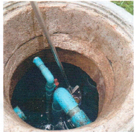
จุดที่ 2 คุณภาพน้ำทิ้งหลังจากออกจากระบบบำบัดน้ำ เสีย บริเวณถังน้ำใส (Effluent tank)
